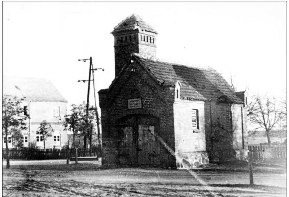
Das alte Spritzenhaus von 1944
